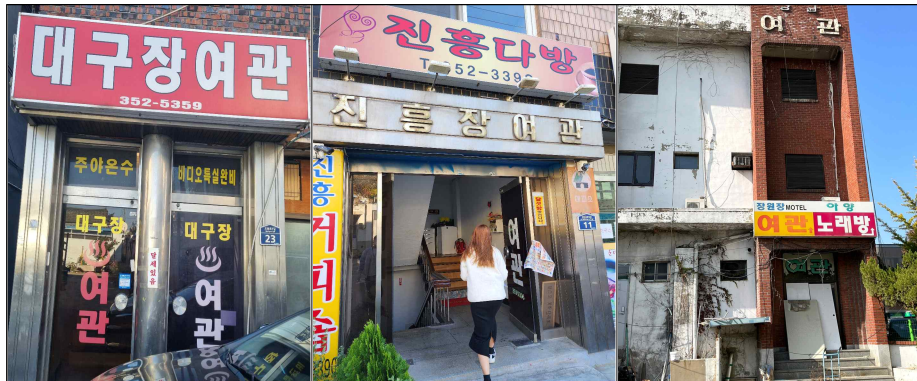
[그림 Ⅲ-2] 실태조사 건물 사진
